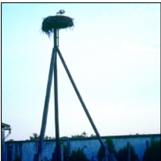
A megfelelő stabilitás érdekében két oldali támasztást kapott a segédoszlopra áthelyezett gólyafészek
