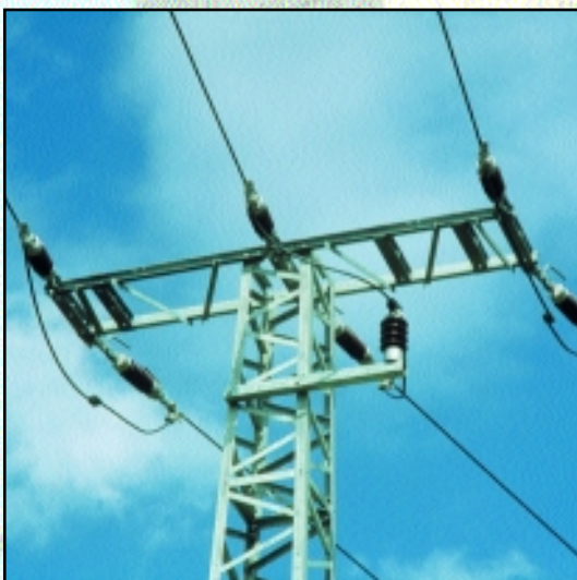
Madárvédelmi szempontból biztonságos oszlopkialakítás, alsó állású vezetőkkel
