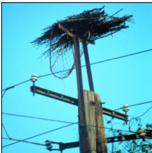
A nyolcvanas években kihelyezett tartókosarak nagy része korrozó miatt cserére szorul
