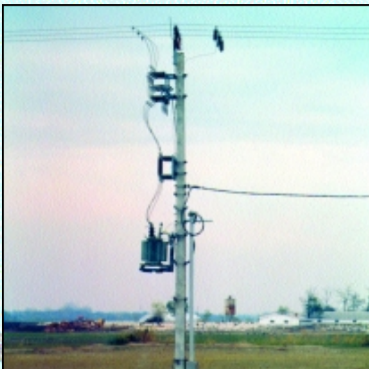
Madárvédelmi szempontból biztonságos oszlopkialakítás, a szerelvények az oszlop oldalán vannak
