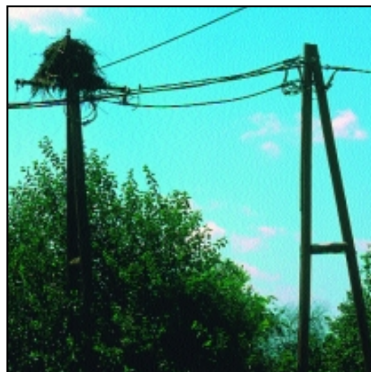
A többkábelerű hálózat átszerelésekor meg nem emelt fészkek idővel leomlanak
