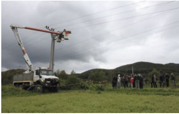
A konferencia résztvevői egy terepi bemutatón, amelynek során egy feszültség alatt lévő 22kV-os vezeték oszlopát szigetelik le (fotó: Z. Guziová) Participants of the Conference during field presentation of insulation 22 kV power lines consoles under full (not switch off) electricity.
