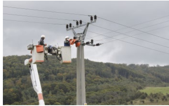
A konferencia résztvevői egy terepi bemutatón, amelynek során egy feszültség alatt lévő 22kV-os vezeték oszlopát szigetelik le (fotó: Z. Guziová) Participants of the Conference during field presentation of insulation 22 kV power lines consoles under full (not switch off) electricity.
