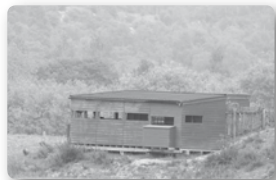
Távolabbi események rejtett megfigyeléséhez megfelelőek a 30-40 cm széles kitekintőrések (Fotó: Orbán Zoltán)
