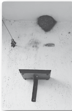
A fecskefészek alá szerelt ürülekfelfogó fecskepelenka sok veszekedést előzhet meg (Fotó: Orbán Zoltán)
