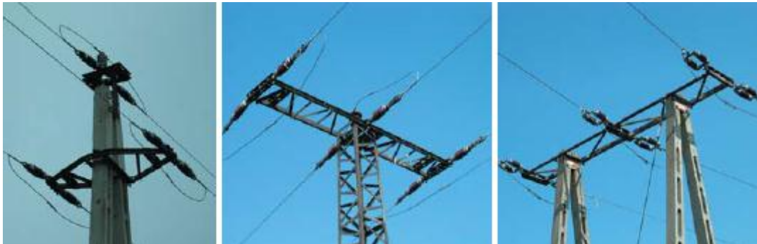
Feszítőoszlopok: háromszög vezetőelrendezés (4); egysíkú vezetőelrendezés fém oszlopon (mivel a középső átkötés felül van átvezetve, ezért kiemelten veszélyes a madarakra) (5); egysíkú vezetőelrendezés beton portál-oszlopon (ez kevésbé veszélyes szerkezet, mivel mindhárom átkötés a k.tartó síkja alatt került átvezetésre) (6).
