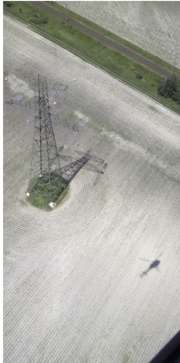
1. ábra: 400 kV-os vezeték tartóoszlopa felülnézetben (fotó: Váczai Miklós) / 400 kV high-voltage pylon from a bird's eye view
